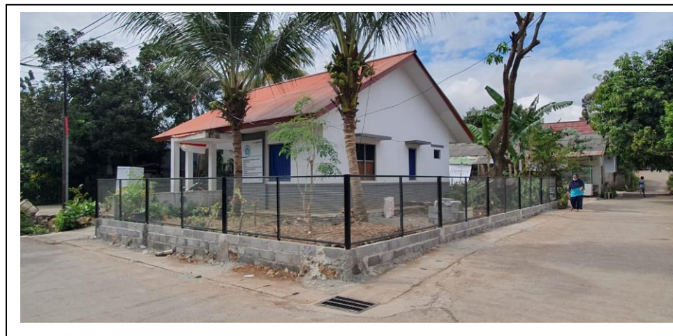
Gambar 5 Kondisi Gedung Posyandu Saat Ini (Tim PkM, 2023)
