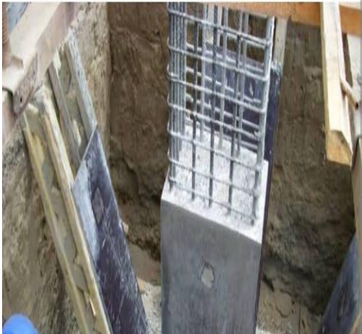
Gambar 6. pondasi dan kolom
