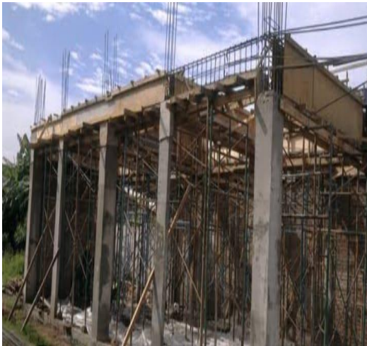
Gambar 8. Kolom dan tulangan balok
