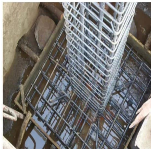
Gambar 5. Tulangan pondasi dan kolom
