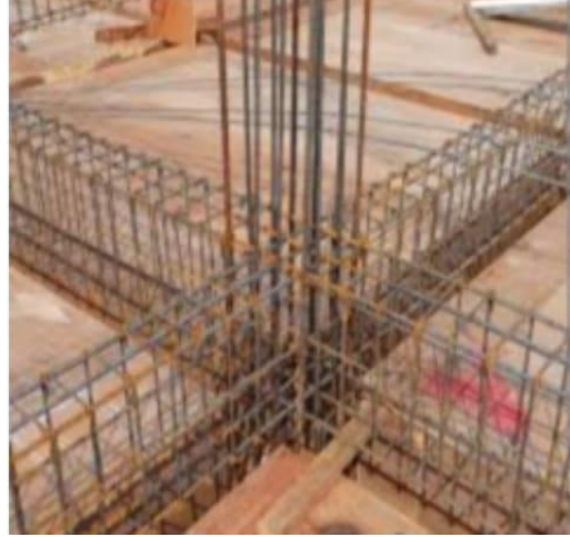
Gambar 7. Tulangan sloop dan kolom
